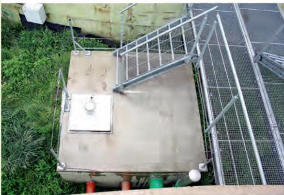
Pumpenschacht in Beton-Fertigteilebauweise zwischen Fermenter und Gärdüngerlager. Der Schacht ist etwa 2 Meter tief in die Erde eingelassen. Einstieg geht nur per Leiter. Der Pumpenschacht kommt fertig vormontiert an die Biogasanlage.
