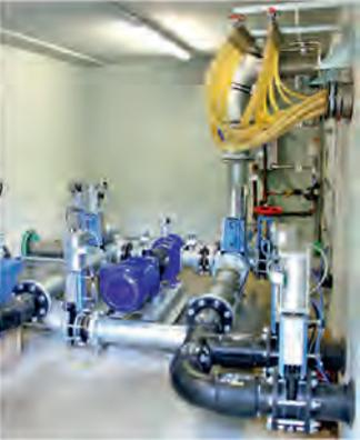
Der Pumpenraum befindet sich in einer Beton-Fertigarage, die komplett vormontiert per Lkw an die Biogasanlage gebracht wird. Mit einem kleinen Kran wird sie dann aufgestellt. Es müssen dann nur noch die Rohrleitungen verbunden werden. Oben rechts im Bild sind die Heizungsrohre (gelb) zu erkennen.
