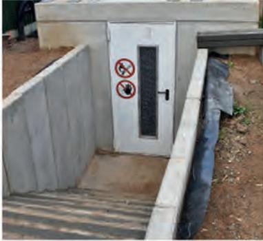
■ Unter anderem die Substratpumpen (rechts) bringt NQ in einem unterirdischen Versorgungsschacht unter, der über eine Luke in der Decke zugänglich ist. Hier ließ der Platz es allerdings zu, Tür und Treppe anzulegen (links).
