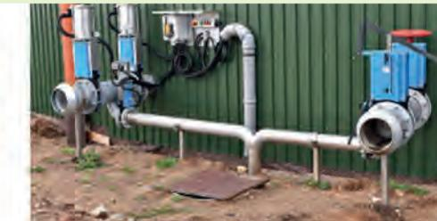
■ Anschlüsse für die Gärrest-Entnahme: Der linke Schieber ist mit Funkbedienung ausgestattet sowie mit zwei Füllstandsmessern gekoppelt.
