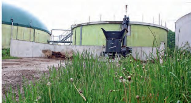
75-kW-Biogasanlage auf dem Hof Potthoff. Rechts am Bildrand ist das offene Wirtschaftsdüngerlager zu sehen. In der Bildmitte ist der Flachdach-Fermenter abgebildet, links daneben steht das Gärdüngerlager mit Gasspeicherhaube. Vor dem Fermenter befindet sich eine betonierte Mistlagerfläche mit Betonwänden. Auf der Mistlagerplatte steht der Rondomat-Feststoffeintrag. Unter der Treppe zwischen Fermenter und Gärdüngerlager hat der Pumpenschacht seinen Platz gefunden.
