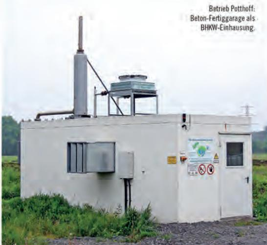
Betrieb Potthoff: Beton-Fertigarage als BHKW-Einhausung.
