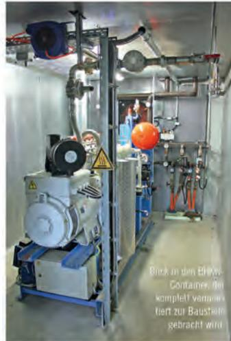
Blick in den EDL-WC-Container, der komplett vormontiert zur Baustelle gebracht wird
