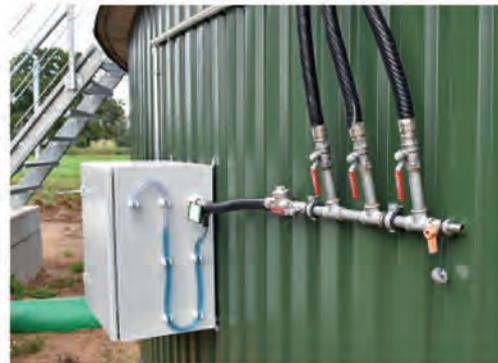
■ Biologische Entschwefelung: Über einen kleinen Kompressor (im grauen Kasten) wird Luft eingeblasen und mit drei Leitungen gleichmäßig verteilt.
