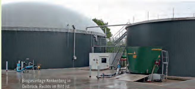
Biogasanlage Kenkenberg in Delbrück. Rechts im Bild ist der Fermenter mit Feststoffdosierer zu sehen. Links im Bild befindet sich das Gärdüngerlager mit Gasspeicher. Zwischen den beiden Behältern steht der Pumpenraum (weiß)
