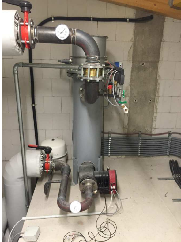
Abbildungen: Power-to-heat-Anlage mit 490 kW el. Leistung
